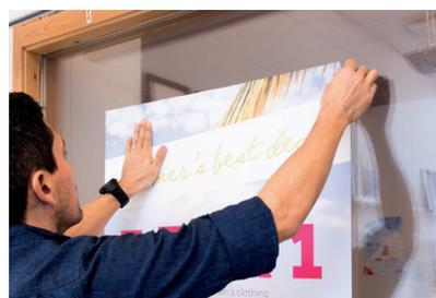
**3.** Utilisez une raclette feutrée pour chasser les bulles d'air. N'utilisez pas d'outils aiguisés pour chasser les bulles d'air.
